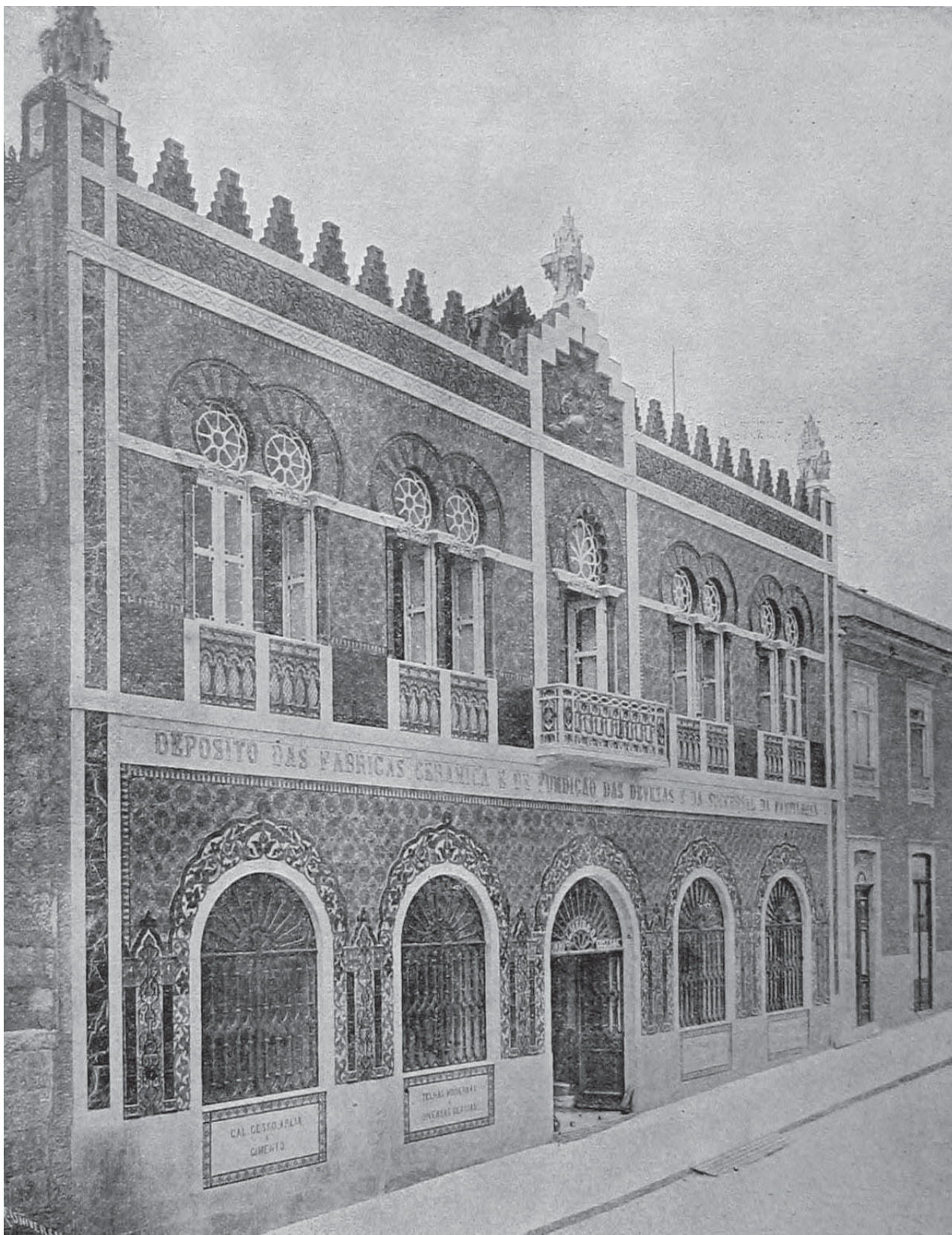
Fig. 2 – O edifício do depósito, por volta de 1904.
