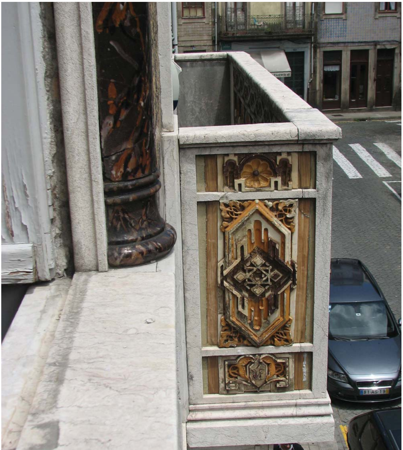
Fig. 4 – Sacada da fachada do depósito, vista de uma das janelas.
