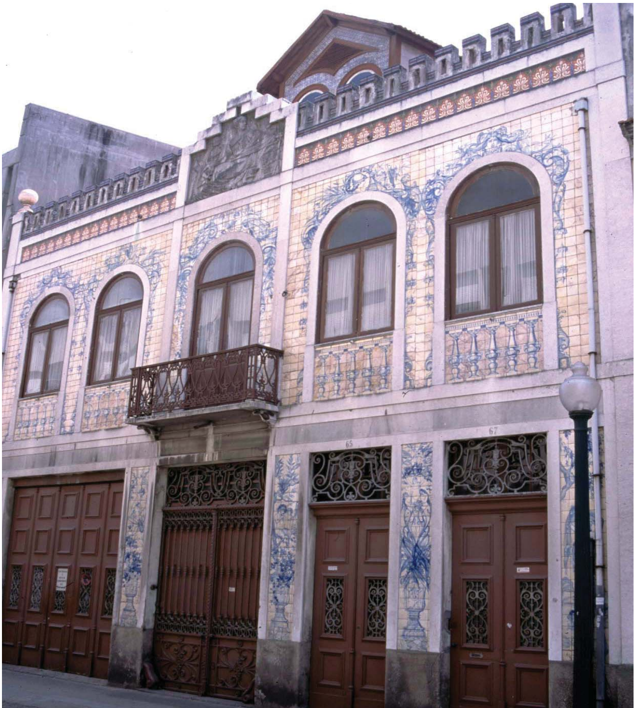
Fig. 6 – Fachada da antiga oficina de mármore.
