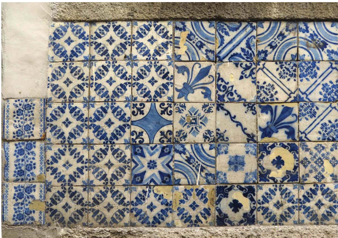
Fig. 7 – Detalhe do alçado posterior da antiga loja da fábrica.
